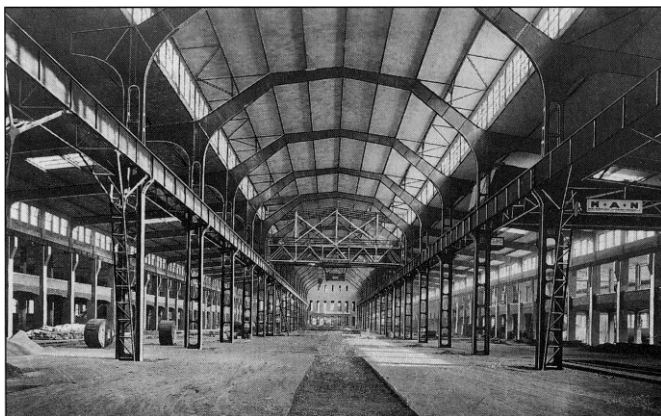
Bild 1 Foto der Messehalle aus der Bauzeit, tragende Stahlkonstruktion im ursprünglichen Zustand [3] Photo of the exhibition hall from the construction period, load-bearing steel structure in its original state [3]
