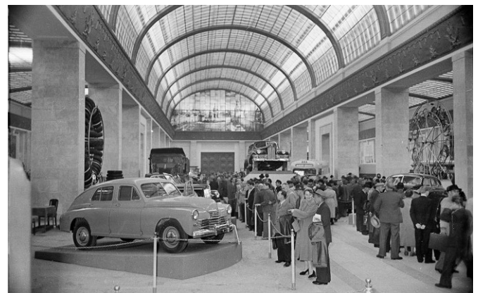
Bild 2 Innenansicht des Mittelschiffs der Messehalle 12 in den 1950er-Jahren [3] Interior view of the central section of exhibition hall 12 in the 1950s [3]
